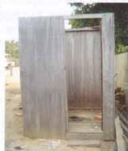
atual banheiro da Igreja
